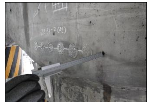
탄산화 깊이 측정
